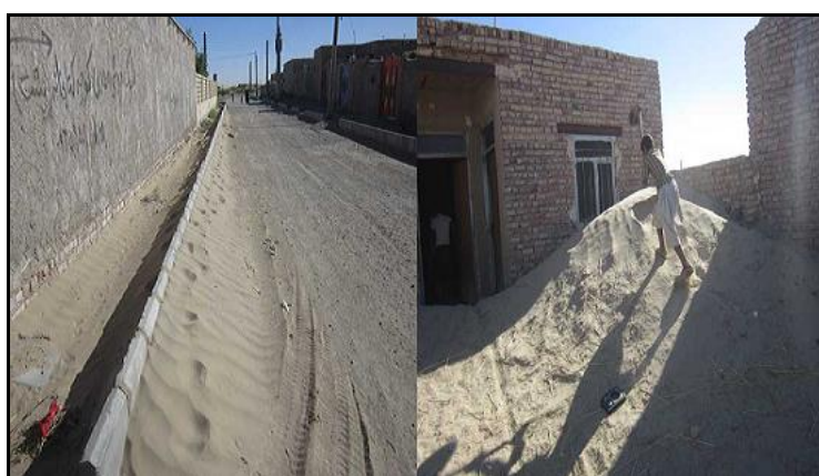
شکل ۶. وضعیت نامطلوب فضای کالبدی شهرک علی اکبر
